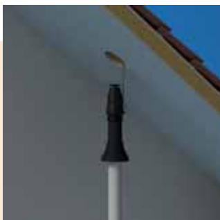
9 Trek aan haak om dakpan te fixeren en duw tegelijk Skyline Inside naar buiten.
