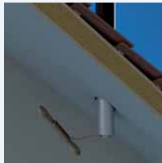
2 Gaatje boren in luchttoevoerpijp en touw vastmaken.
