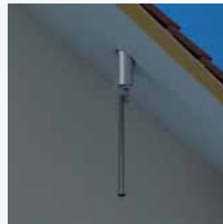
3 Knikarm plaatsen en touw enigszins op spanning houden.
