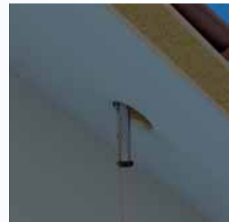
4 Doorvoer naar buiten drukken met behulp van knikarm. Doorvoer kantelen door zwarte knop onderaan naar rechts te draaien.
