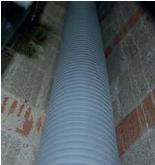
De MultiFlex-afvoerslang kan zonder gevolgen uitzetten.
