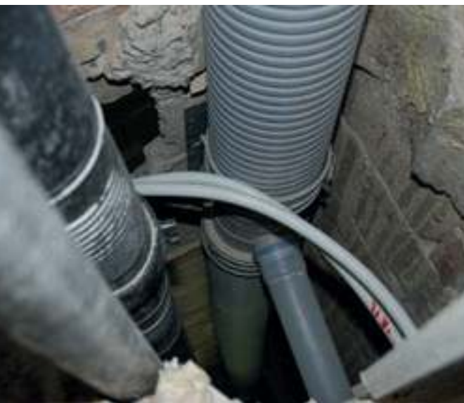
MultiFlex in bestaande schacht.
